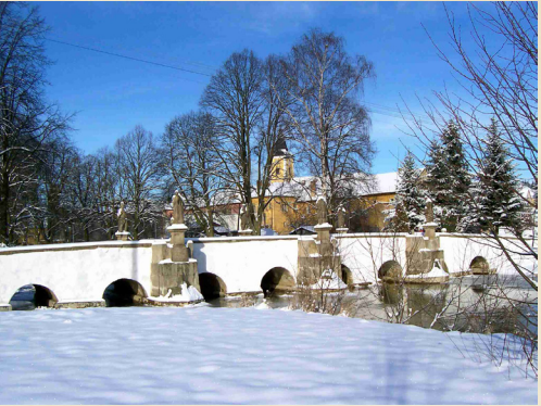
Most přes Radbuzu Die Brücke über den Fluss Radbuza The bridge over the Radbuza river
