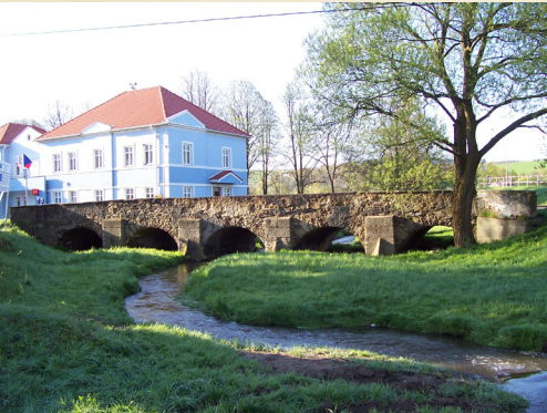
Most přes Bezděkovský potok Die Brücke über den Bach Bezděkovský The bridge over Bezděkovský brook
