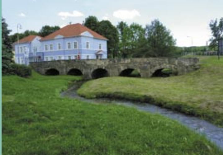
Most přes Bezděkovský potok - Die Brücke über den Bezděkovský-Bach - The bridge over Creek of Bezděkov
