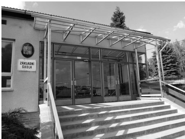
Nový vstup do základní školy
